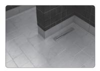
4 N'activez pas le plancher chauffant avant l'expiration du temps de séchage de la colle recommandé par le fabricant. En général, la durée est d'à peu près 28 jours. Afin de connaître le délai d'attente exact, veuillez suivre les instructions du manufacturier de la colle à carreler qui a été utilisée.
