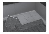
3 Afin de vérifier le niveau de contact avec la membrane, soulevez la premier carreau afin de vérifier qu'ils soient bien recouverts de ciment-colle.
