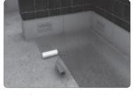
2 Il est fortement recommandé d'appliquer un apprêt avant l'installation de la membrane.
